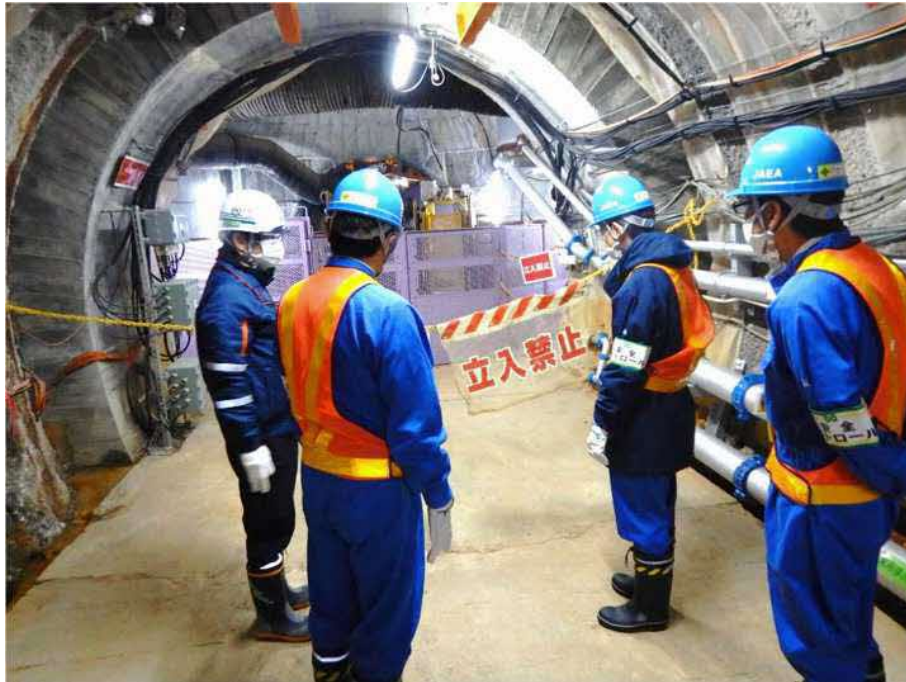
図 33 安全パトロールの様子
